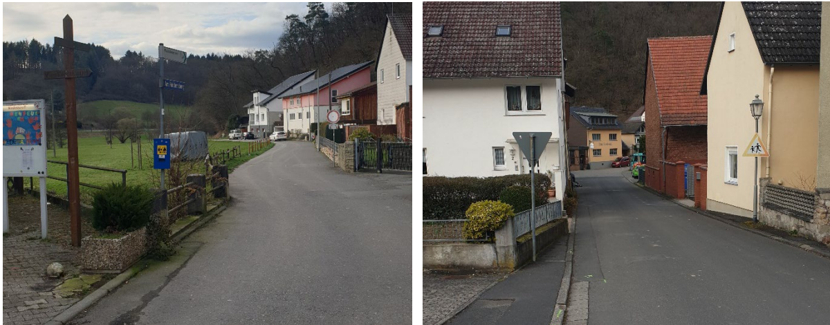
Abb. 7: Straßenverkehrsfläche Am Holdersberg (links) und Brunnenstraße (rechts)
