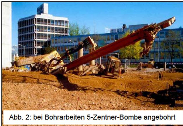
Abb. 2: bei Bohrarbeiten 5-Zentner-Bombe angebohrt
